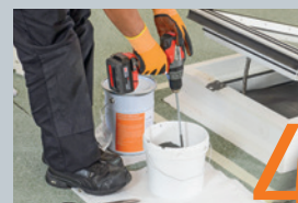
Rozmíchat tekutou hydroizolaci
