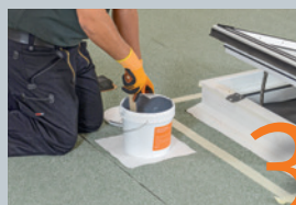
Rozmíchat tekutou hydroizolaci
